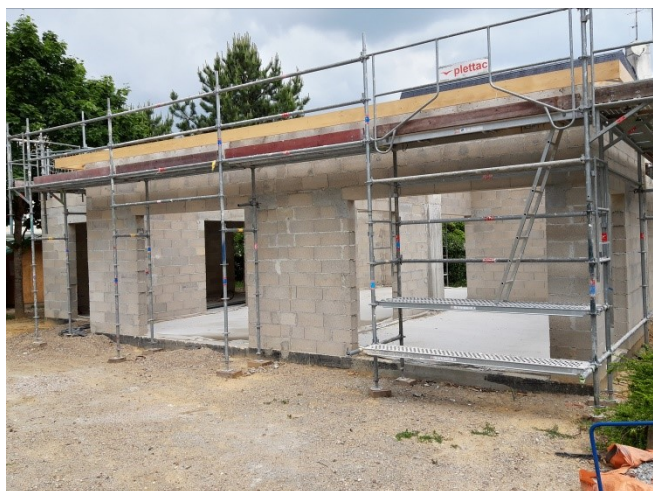
Le PASA en chantier en 2018.
