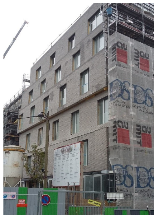
Le futur bâtiment de Saint-Joseph en travaux en 2018
